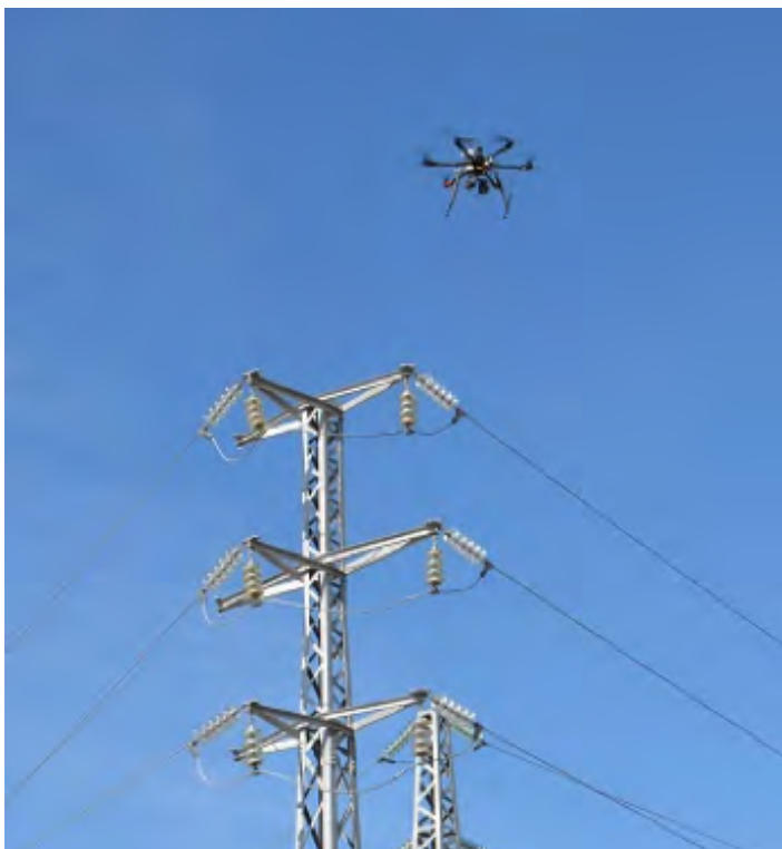
Figura 9. Monitoreo de instalaciones de energía y tuberías. (Brasa, 2016).
